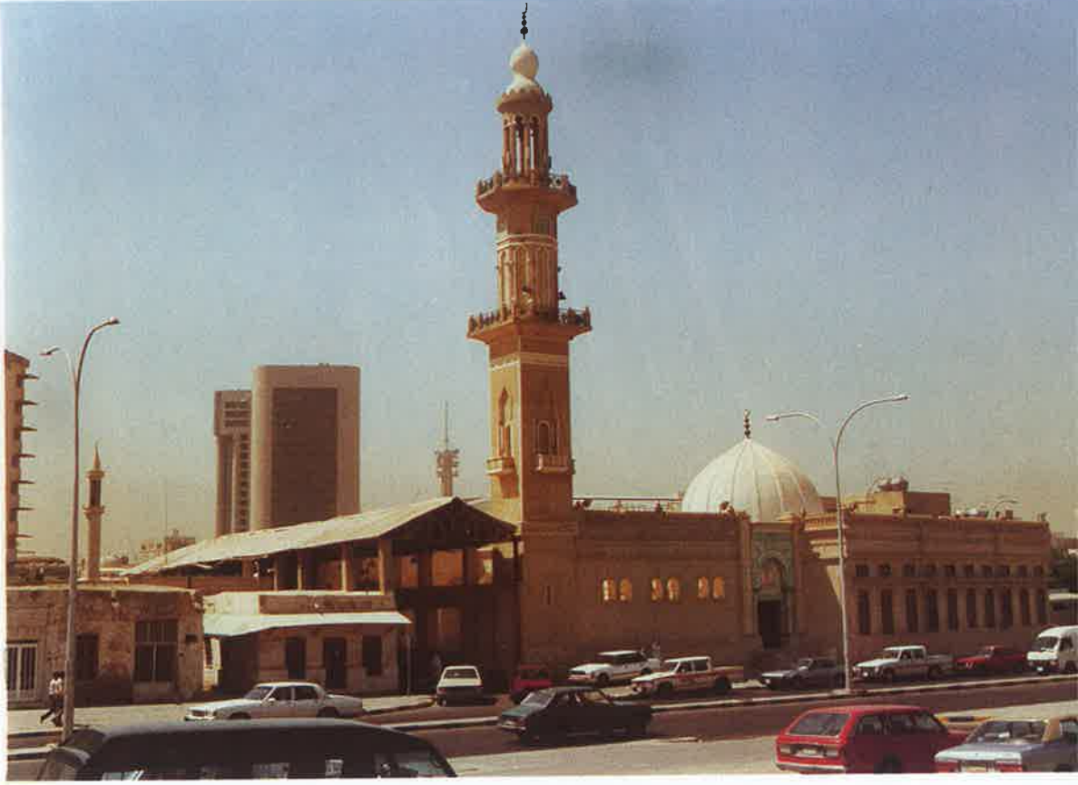
السوق الداخلي قبل هدمه وتجديده ويبدو عن يمينه مسجد السوق الكبير وعن شماله بقايا سوق البدر قبل تجديده أيضا
