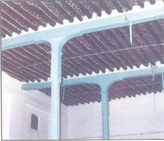
سقف لأحد المساجد القديمة وتُشاهد «الصور» وهي تحمل الجندل الذي يرتكز عليه السقف
