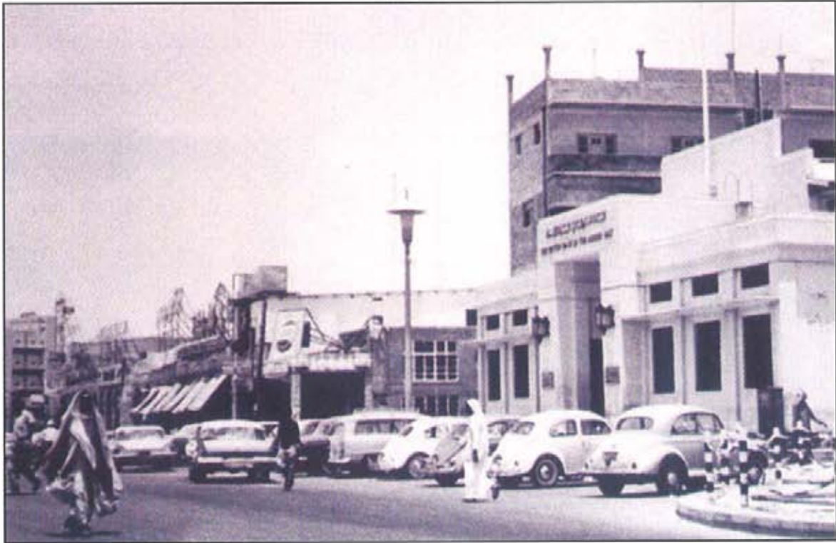
مبنى البنك البريطاني للشرق الأوسط (يمين) الذي تم افتتاحه عام ١٩٤٩م في الصفاة
