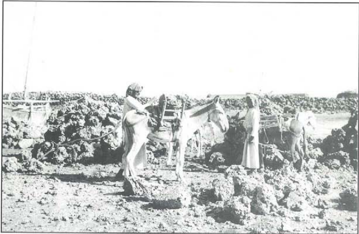
تستخدم الحمير لنقل الصخور من النقع إلى مواقع البناء . وتجلب الصخور من عشيرج بالنشاشيل التي تنزلها في النقع على شكل أكواد .
